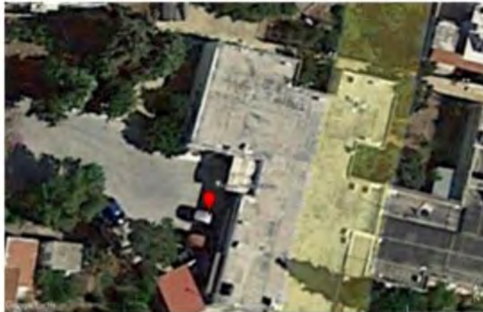
Εικόνα 35: Χώρος στάθμευσης στο Κέντρο Υγείας στο Χάρακι (Υπόβαθρο Google Earth- Αεριομετρής απεικόνιση)
