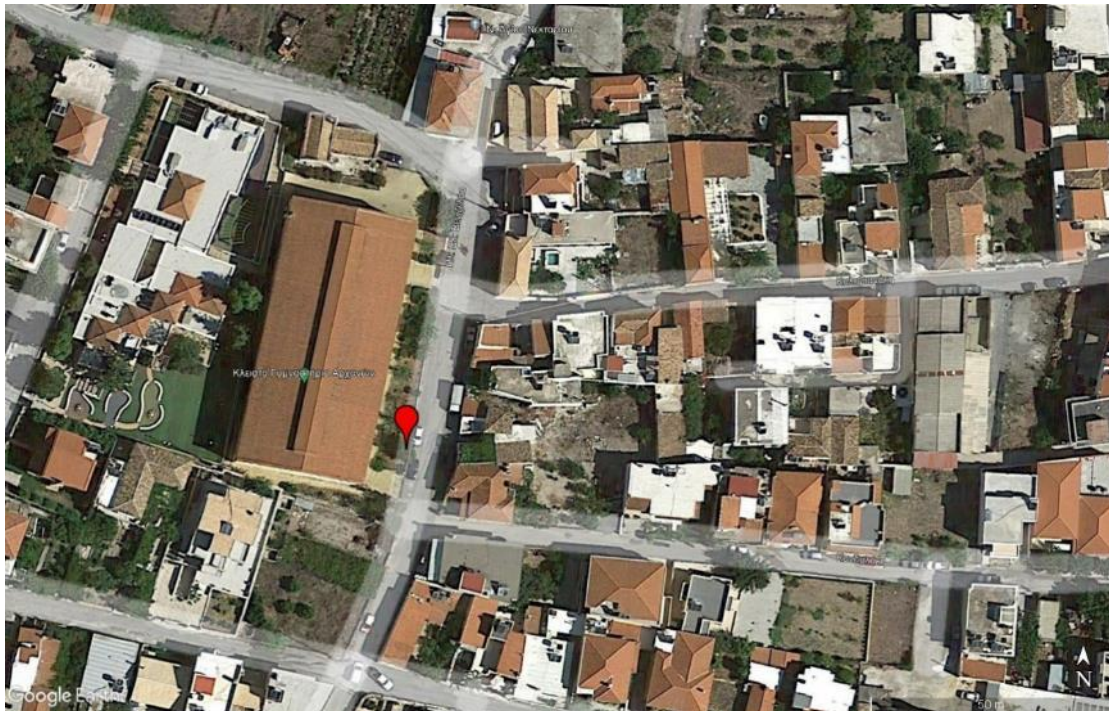
Εικόνα 10: Θέση επί της οδού Πλ. Ελ. Βενιζέλου έξω από το Κλειστό Γυμναστήριο Αρχανών (Υπόβαθρο Google Earth)
